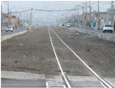
(1) Vía Férrea, N. Tirado al Norte
