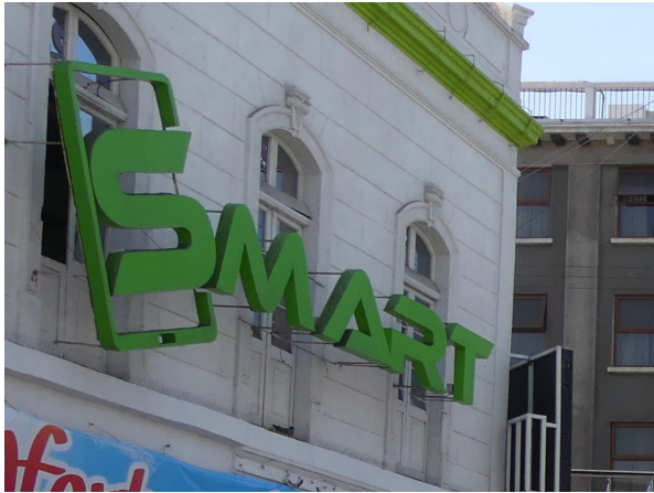
Figura 244_ Es inapropiado que un letrero obstaculice ventanas. [Barrio Centro, Antofagasta]
