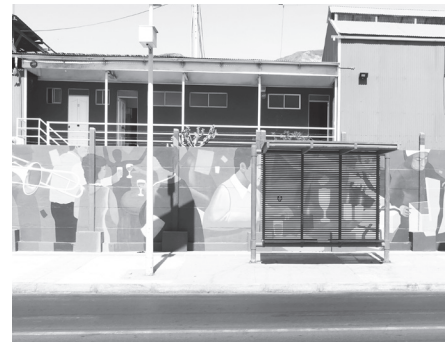
Figura 152_ Es inapropiado que un paradero ocupe gran espacio de la acera, dificultando la movilidad peatonal. [Barrio Estación, Antofagasta]
