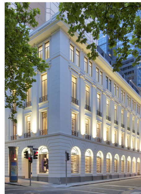
Figura 261_ La iluminación puede acentuar la estética de la fachada. [Melbourne, Australia]
