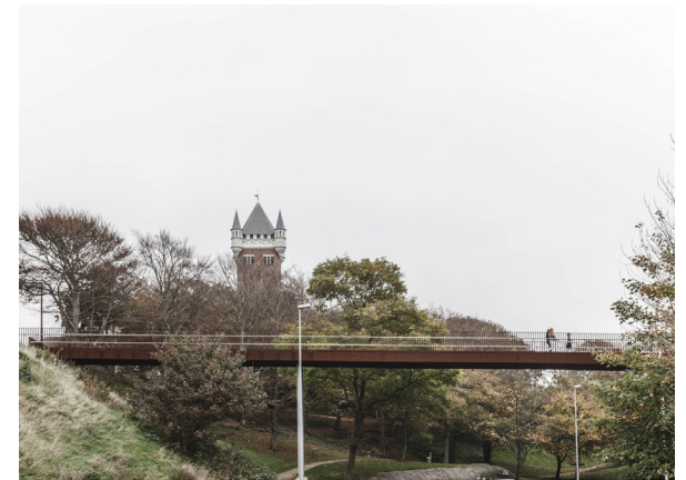
Figura 94_La pasarela como elemento distintivo del entorno. [Esbjerg, Dinamarca]
