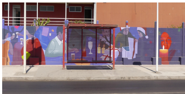
Figura 297_Los paraderos en los Barrios Centro y Brasil tienen un diseño simple pero poco eficiente por la falta de infraestructura necesaria. [Barrio Estación, Antofagasta]
