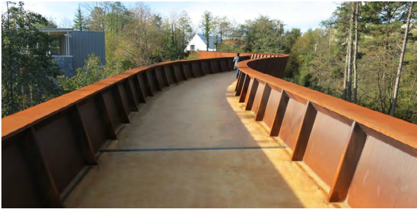
Figura 70 _Fotografía referente para Pasarela Peatonal. [San Sebastián, España]
