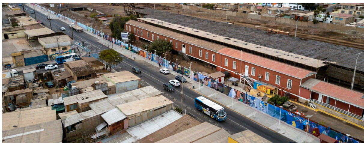
Figura 8_Vista general mural en calle Valdivia. [Barrio Estación]
