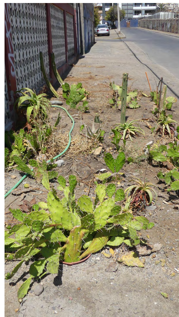
Figura 80 _La falta de vereda en las aceras y la ocupación con jardines dificulta la movilidad peatonal. [Barrio Estación]
