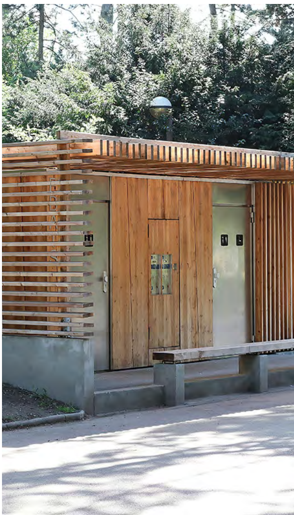
Figura 324 Un volumen simple y con materiales relacionados con el entorno funciona bien para los baños públicos. [Lyon, Francia]
