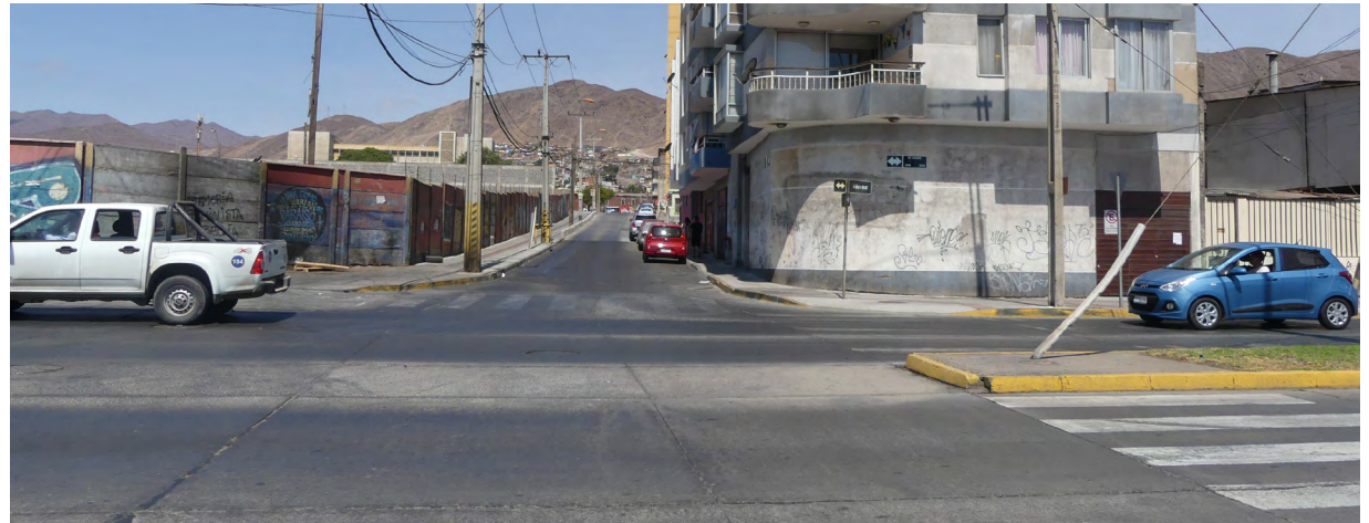
Figura 92 La isla peatonal central no cumple criterios de accesibilidad universal. [Barrio Estación]
