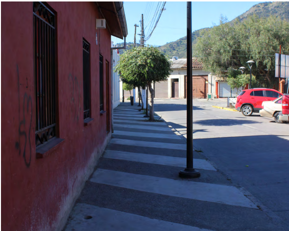
Figura 129_ El uso de un mismo material pero con distinta terminación y tono permite mantener bajos costos en los proyectos. [Peumo, Región del L. B. O'Higgins]
