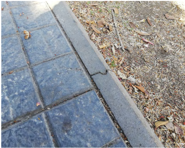
Figura 138_ La unión macho-hembra es recomendable para las solerillas. [Santiago, Región Metropolitana]
