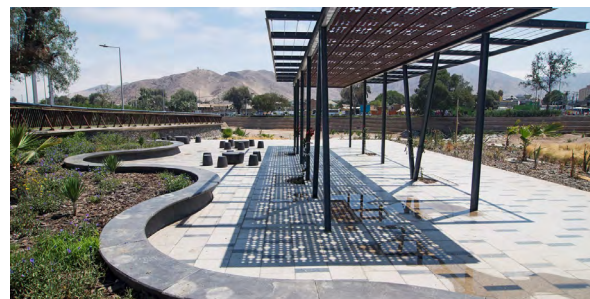
Figura 332_ La densidad del elemento de cubierta debe permitir generar un espacio con buena sombra. [Copiapó, Región de Antofagasta]
