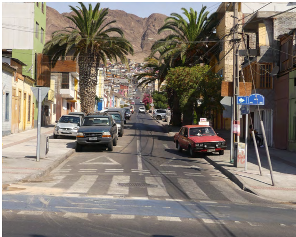
Figura 235_ Señalética ubicada en el borde exterior de la acera, cercana a las soleras y sin interrumpir el flujo peatonal. [Barrio Estación]
