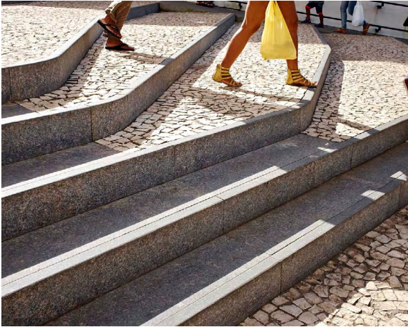
Figura 128_ Los pavimentos de piezas unitarias e instalación artesanal deben limitarse a áreas emblemáticas. [Salvador, Brasil]
