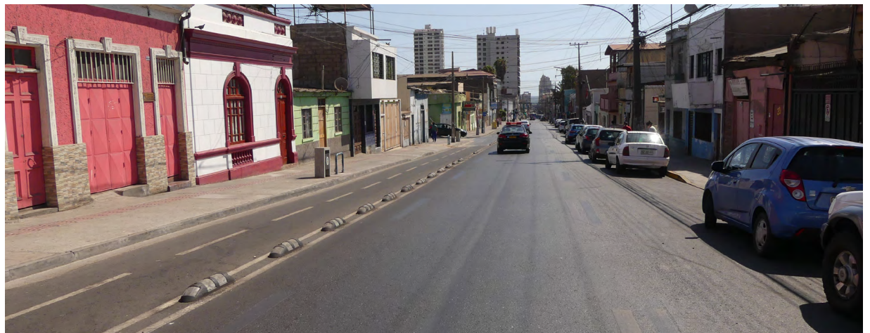
Figura 94_La demarcación en la calzada se encuentra con desgaste, así como existe una ocupación irregular de estacionamientos que reducen el espacio vehicular. [Barrio Estación]
