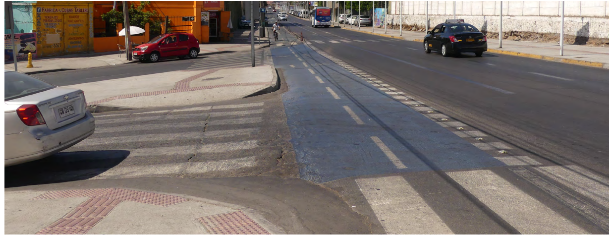
Figura 91 Es correcto que los cruces peatonales priman sobre las demarcaciones de las ciclovías. Sin embargo, en este caso el rebaje de vereda es deficiente y se encuentra en posición diagonal. [Barrio Estación]
