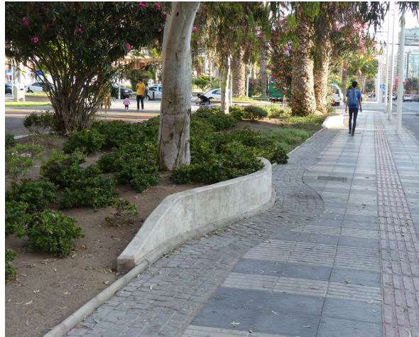
Figura 140_ Un uso apropiado de borde de hormigón y adoquines como remate del pavimento. [Barrio Brasil]
