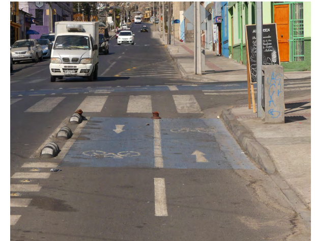
Figura 136_ La demarcación de las ciclovías no debe interrumpir los cruces peatonales. [Barrio Estación]
