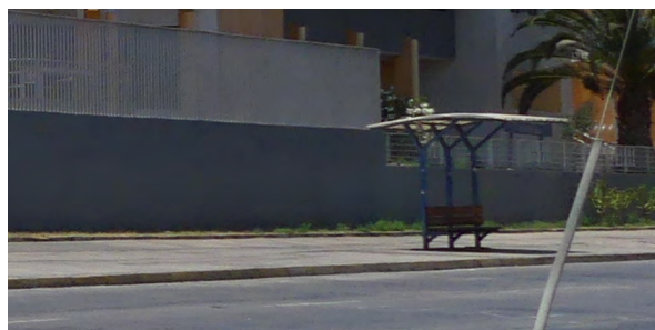
Figura 224 El paradero no cuenta con la señalética mínima y necesaria para un correcto funcionamiento [Barrio Centro]
