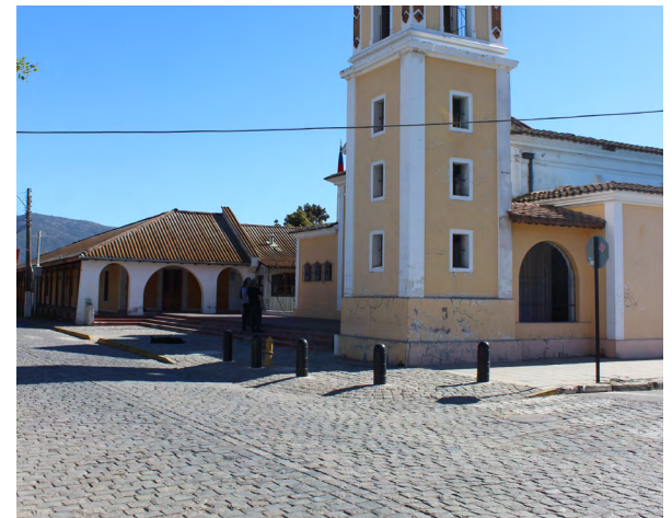
Figura 109_ El uso del mismo material en la calzada y vereda debe limitarse a espacios particulares, como áreas patrimoniales y con las medidas de seguridad necesarias. [Peumo, Región de O'Higgins]
