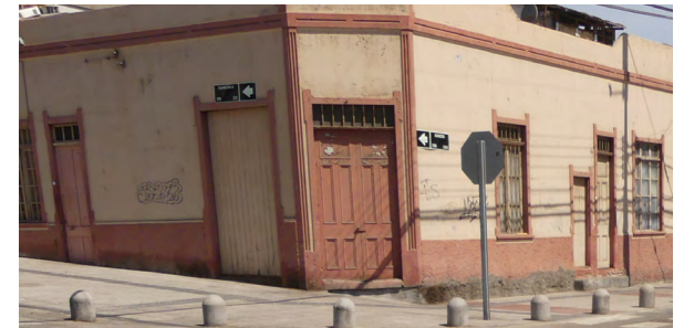
Figura 221_ La altura de los letreros no coincide. En este caso debería primar el letrero que se ajusta a las líneas principales de la fachada. [Barrio Estación]
