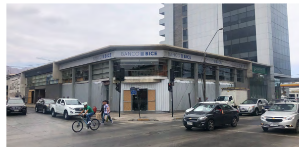
Figura 243_ La estética del letrero se adapta a las líneas de arquitectura contemporánea, sin embargo, el blindaje no es apropiado. [Barrio Centro]
