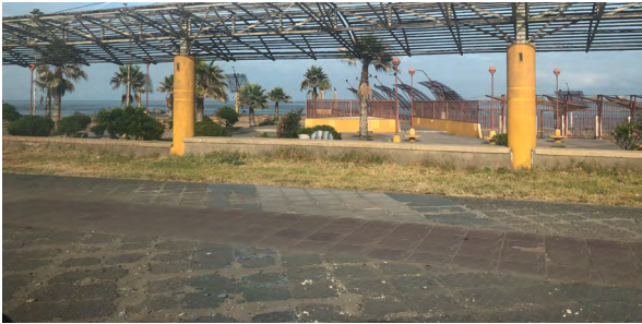
Figura 264 _Banca en borde construido en obra, bajo un elemento tipo sombreadero degradado. [Borde Costero]
