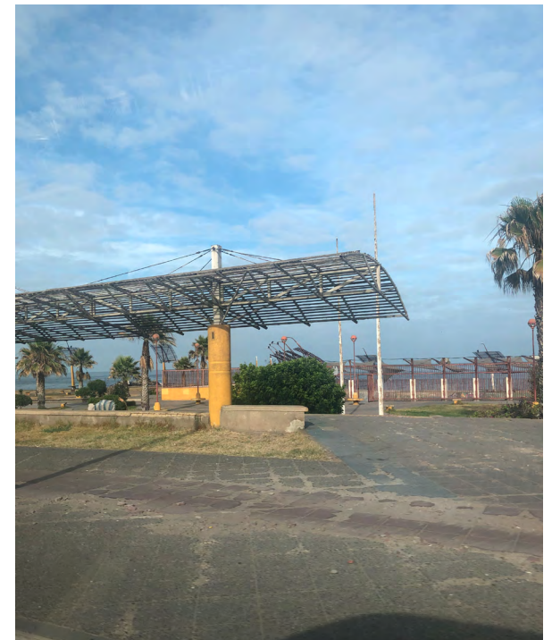
Figura 103_Pavimento gravemente desgastado. [Borde Costero]
