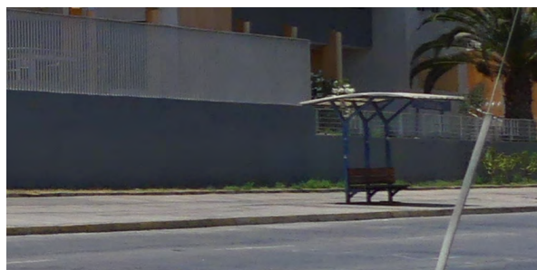
Figura 246_ El paradero no cuenta con la señalética mínima y necesaria para un correcto funcionamiento [Barrio Centro]
