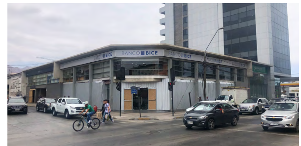
Figura 265_ La estética del letrero se adapta a las líneas de arquitectura contemporánea, sin embargo, el blindaje no es apropiado. [Barrio Centro]
