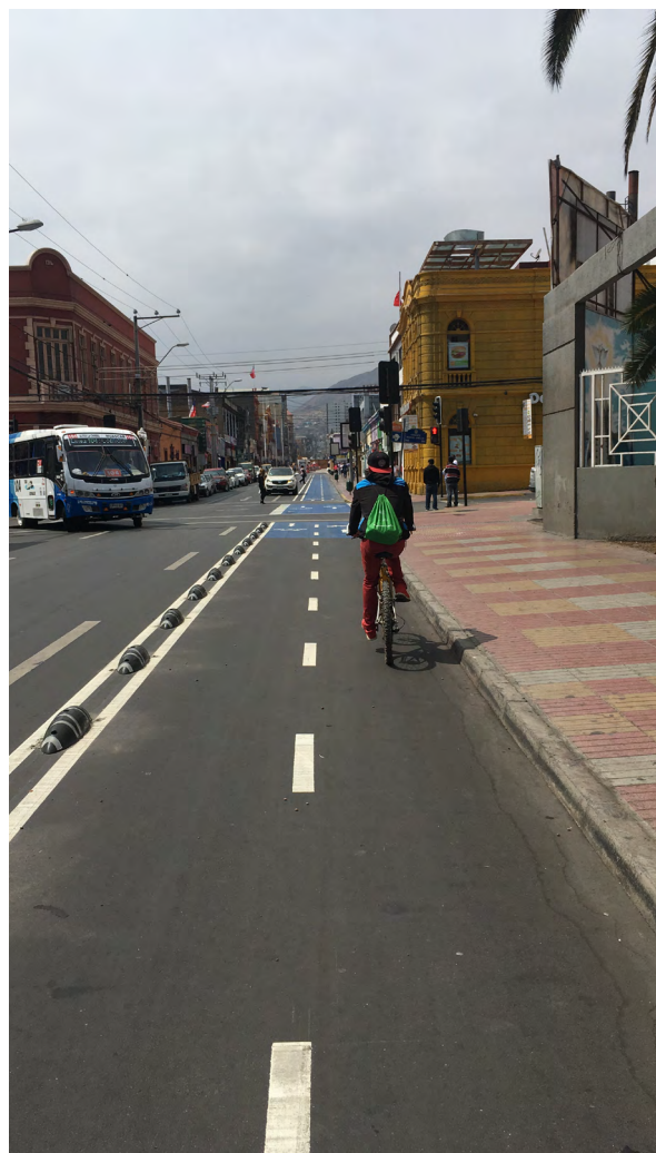
Figura 98 _La ciclovía funciona como un segregador entre vereda y calzada vehicular. [Barrio Centro]
