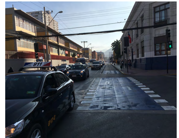
Figura 138_ La demarcación de las ciclovías está subordinada a los cruces peatonales. [Barrio Centro]
