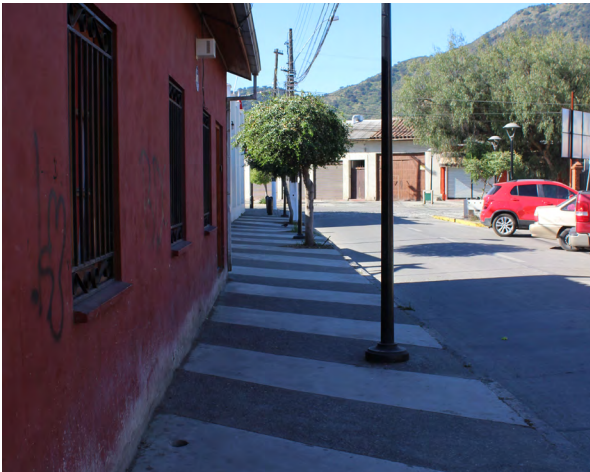
Figura 131_ El uso de un mismo material pero con distinta terminación y tono permite mantener bajos costos en los proyectos. [Peumo, Región del L. B. O'Higgins]
