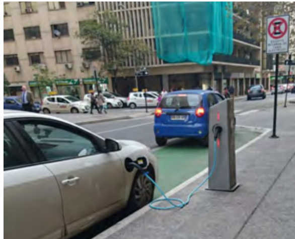
Figura 317_ Tótem de carga sobre la acera, con facilidad para manipularlo en el vehículo. [Santiago, Región Metropolitana]
