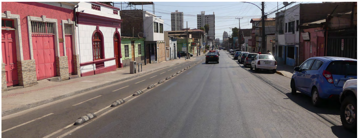
Figura 96_ Calzada vehicular ocupada por estacionamientos con una señalética poco clara sobre los usos permitidos. [Barrio Centro]
