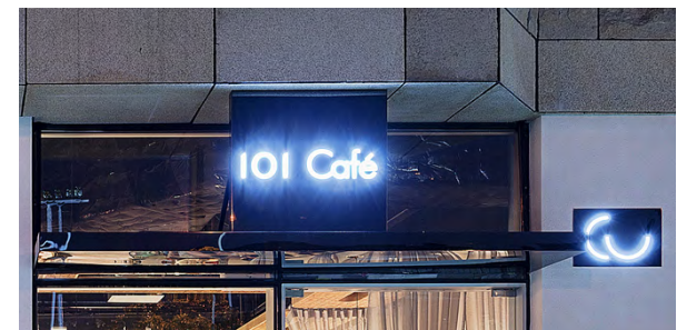
Figura 266_ La estética del letrero se adapta a las líneas de arquitectura contemporánea, sin embargo, el blindaje no es apropiado. [Barrio Centro]
